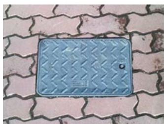
Pojezdový poklop - nosnost 12,5 t
