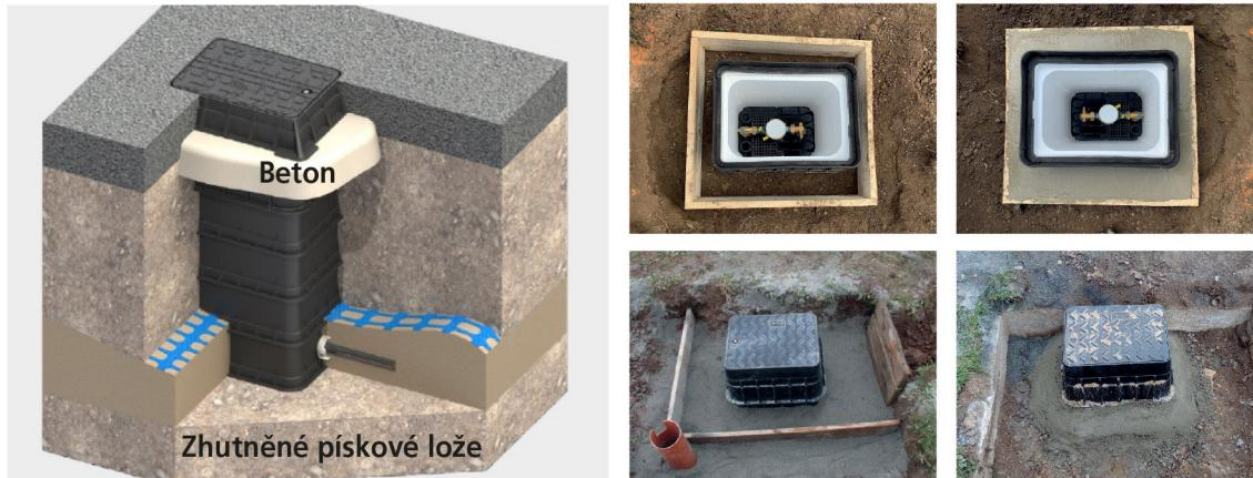
Pro odolnost proti zamrznutí je nutné, aby šachta byla řádně zahrnuta s úrovní terénu, nesmí přesahovat nad terén více než 2 cm. V opačném případě hrozí zamrznutí a zaniká garance odolnosti proti mrazu!!!
